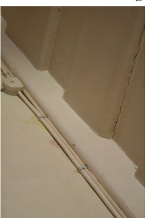
Tyyppilinen pinta-asennus keittiön (105) seinällä.
