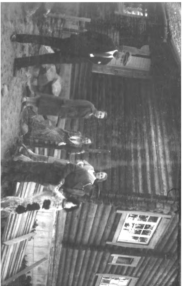
Kuva 1930..40-luvun vaihteesta. Ennen avokuisin kohta on vielä hahmotettavissa vaaleammista pyöröhirsiä. Päätysinäällä "Ainon huoneen" uudempi ikkuna, johon "epäloogisesti" on tehty kaarevanmuukiset vuorilaudat, kietion lisäksi. Päättyjüksivun alaosassa näkyy myös kaksi vaaleampaa hirsiertää, jotka lisätin talon uudelleenytyksien yhteydessä. Kuva: A.C. v. "Ainon huone" -mulyasussaan.
