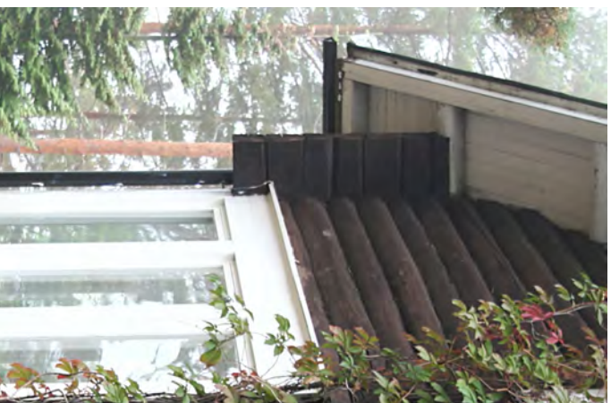
Nurkkasalvoktien ulkoneminen leveiden räystääden kannattamiseksi on yksi tyypillisistä ominaisuuksista Sonckin pyöröhuonekatteluissa. Vasemmalla ja alla Villa Enckellin veistettyä muotoja, oikealla Ramsbyttarin suoraviivainen nurkka. (Ouluus 2006 )
