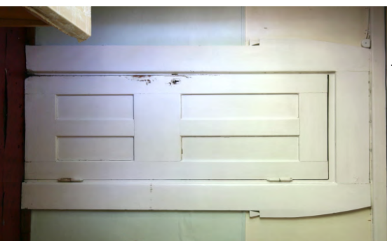
Ruokaalusta ulos, eteistätkkään johtava ovi, jossa lasi on korvattu ilmeisesti mörhemmin levyillä. Alla kolme korkeaa ja kolme nelimäistä peiliä.
