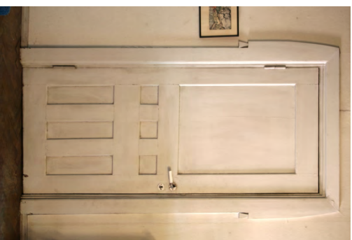
Ruokaalusta ulos, eteistätkkään johtava ovi, jossa lasi on korvattu ilmeisesti mörhemmin levyillä. Alla kolme korkeaa ja kolme nelimäistä peiliä.
