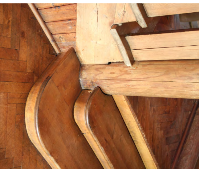
^ Cooperien aikaan, 1940-luvun lopulla tehtyä koivupintaa lattiaa. 18x65 kokoisesta pontatusta puusta suomukuvion on tehty ladonta. Kuvassa portaanaluskappista löytyneitä malli- ja varakappaleita lattiapuusta.
