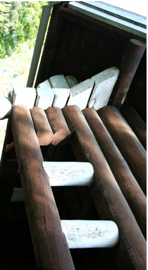
Nurkkasalvoktien ulkoneminen leveiden räystääden kannattamiseksi on yksi tyypillisistä ominaisuuksista Sonckin pyöröhuonekatteluissa. Vasemmalla ja alla Villa Enckellin veistettyä muotoja, oikealla Ramsbyttarin suoraviivainen nurkka. (Ouluus 2006 )
