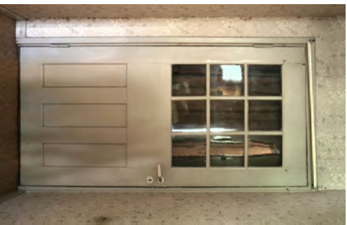
Lasioven malli, jossa lasi 9-rututinen ja alaosassa kolme peiliä, ovi entisen ulkokuistin, nykyisen "Anon huoneen" ja salin välillä.
