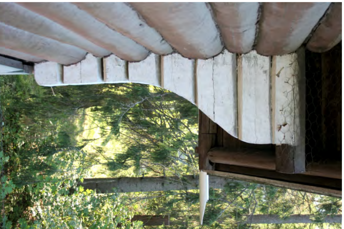
Nurkkasalvoktien ulkoneminen leveiden räystääden kannattamiseksi on yksi tyypillisistä ominaisuuksista Sonckin pyöröhuonekatteluissa. Vasemmalla ja alla Villa Enckellin veistettyä muotoja, oikealla Ramsbyttarin suoraviivainen nurkka. (Ouluus 2006 )
